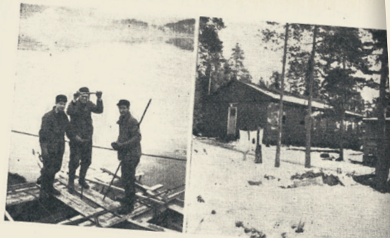
Fra venstre: Grunnundersøkelser ved anlegg av ny vei. Brakka hvor guttene bor. Guttene tar en pause i strevet, mens gravemaskinen laster en bil.
